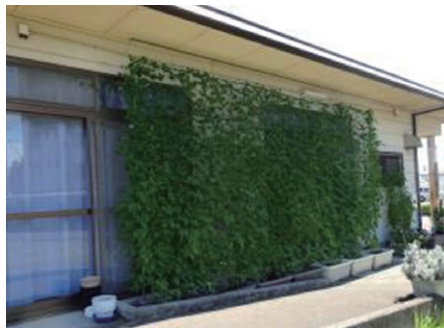
市営小堤団地集会所
